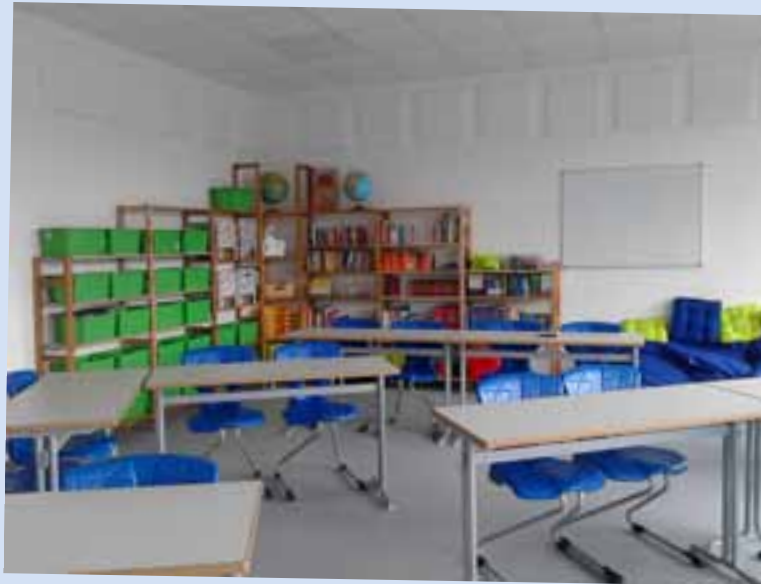
Lärmdämmplatten unterhalb der Decke sorgen für bessere Akustik
