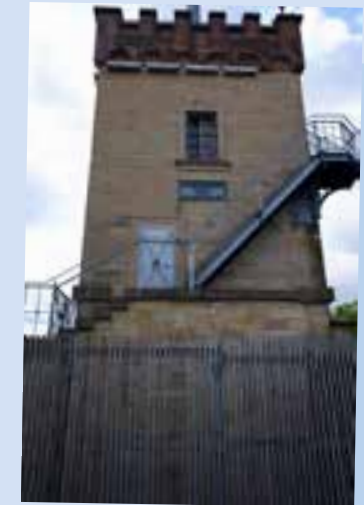
Aus dem Verlies wurde mit den Jahren ein recht ziviler Wasserturm
