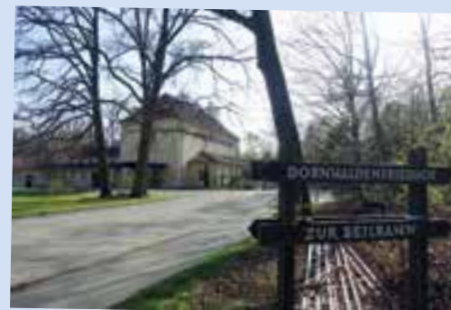
Das Empfangs- und Verwaltungsgebäude des Waldfriedhofs unweit der Seilbahnstation und in der Nähe des Dornhaldenfriedhofs
